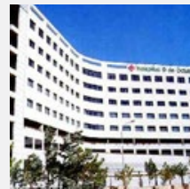
Hospital 9 de Octubre (VALENCIA)
